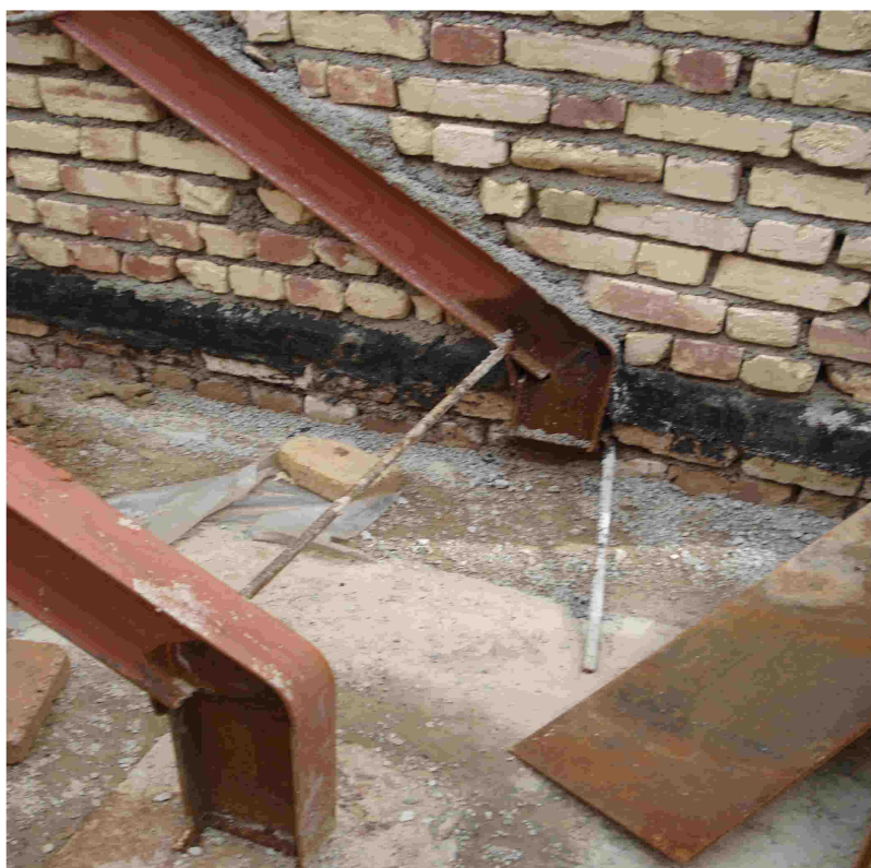
شکل شماره ۱۴- بازهم عدم اجرای فونداسیون در قسمت انتهایی شمشیری پله http://omidi2010.blogsky.com (وبلاگ مهندس امیدی)
