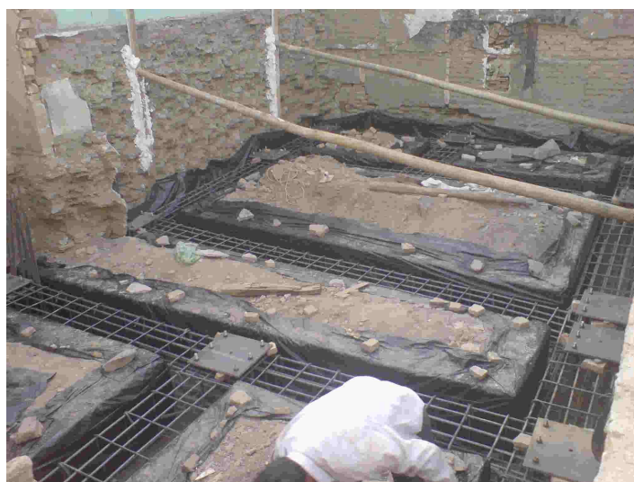
شکل شماره ۱۱- استفاده از ملات گچ والارهای چوبی نامناسب برای مهار دیواره خاکی گود که کاریست بسیار غیر اصولی و خطرناک (حتما باید از پروفیل‌های فولادی که با نبشی و جوش مهار شده باشند برای این کار استفاده کرد)
