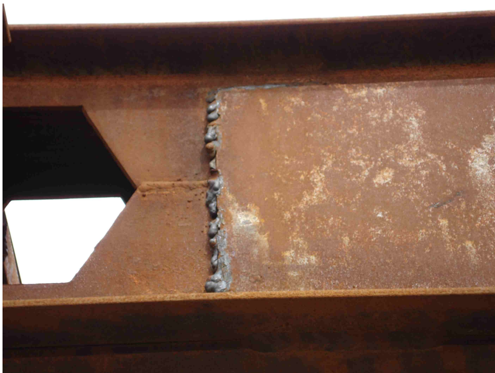
شکل شماره ۳۲- جوش بسیار بد (کاملاً غیر یکنواخت) در اتصال پلایت پرکننده یک تیر لانه زنبوری
